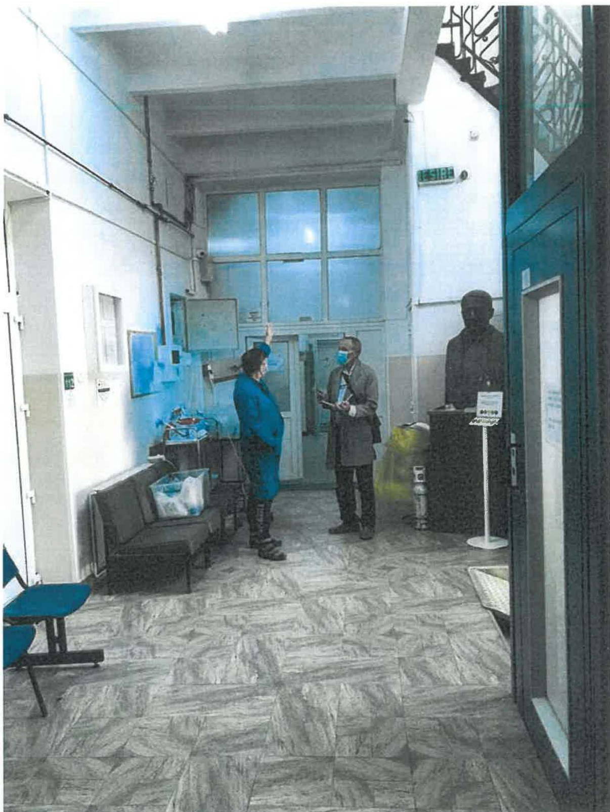
FOTO.24 – Iluminat de siguranta necorespunzator parter Pav. I.
