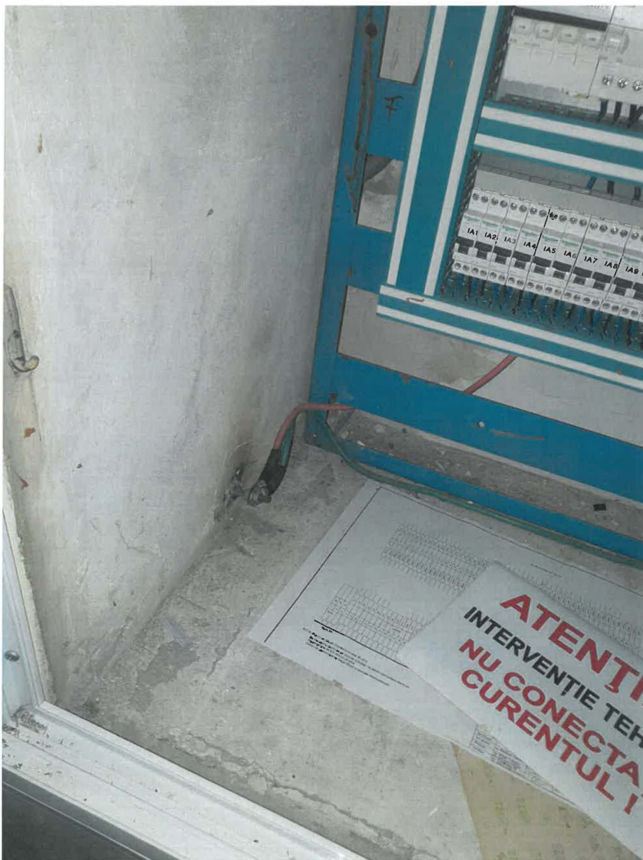
FOTO.11 – TE-A2, echipamente, legatura la pamant.
