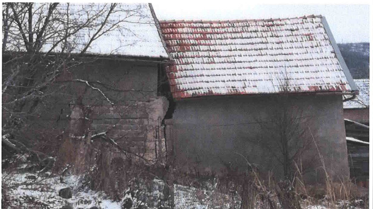
Fig. 8 Fenomene de instabilitate vizibile din deschiderea rosturilor dintre caselor învecinate. Fisuri vizibile în tencuială - Citirea 4
