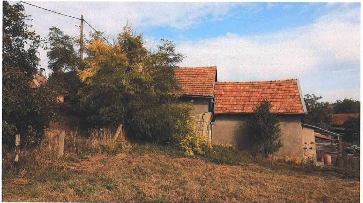
Fig. 7 Fenomene de instabilitate vizibile din orientarea copacilor, înclinarea coamelor caselor învecinate - Citirea 3
