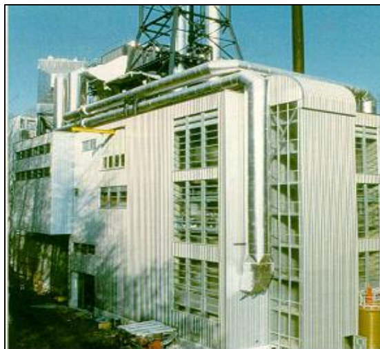
Figura 21: Incinerator de deseuri in Suedia
